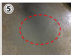
⑤セメントで仕上げ施工 完了
