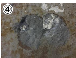
④コーキングを研り止水の 確認
