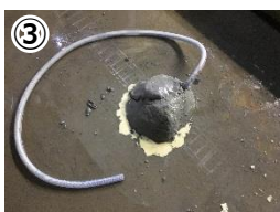
③注入終了状況
