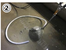
②導水チューブを設置。 口元コーキング後、ガン パンSRCを注入
