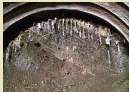
盛土区間の切羽状況
