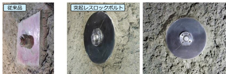
突起レスロックボルト試験施工
