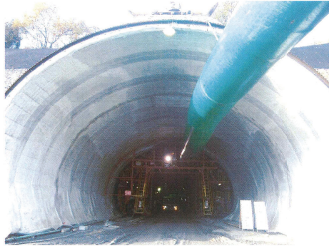
▲ 背面平滑型トンネルライニング工法 (FILM)による防水シート展張
