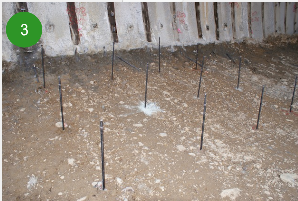
PT-ANCHOR 建込み完了
