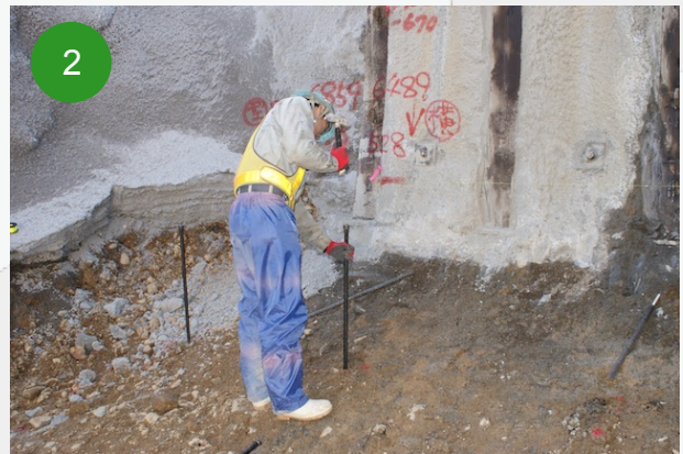
ボルト打込み
