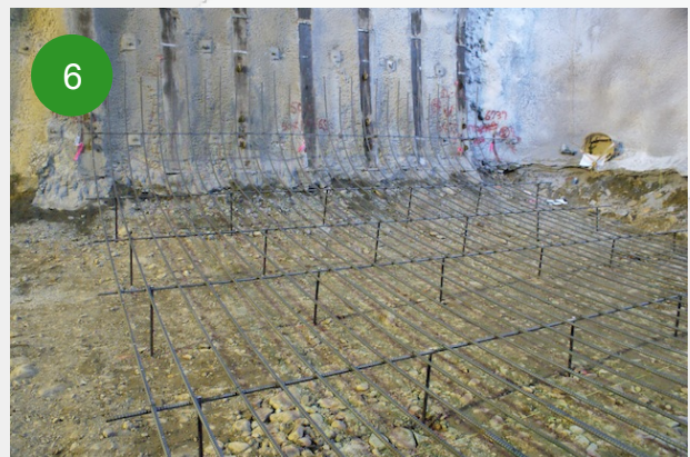
インバート鉄筋 施工状況
