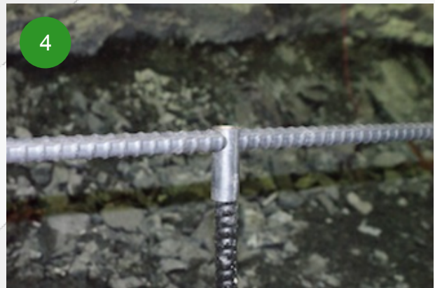
通し鉄筋 組込み状況
