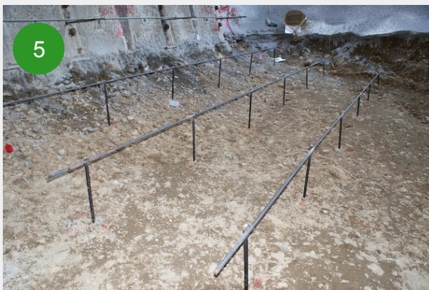
通し鉄筋 設置完了
