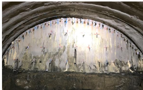
AGFタフライトの打設完了状況
