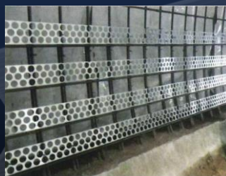
トンネル覆工(有筋区間)
