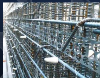
排水機場中壁
