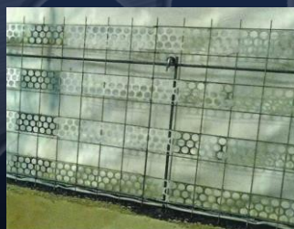
トンネル覆工(無筋区間)
